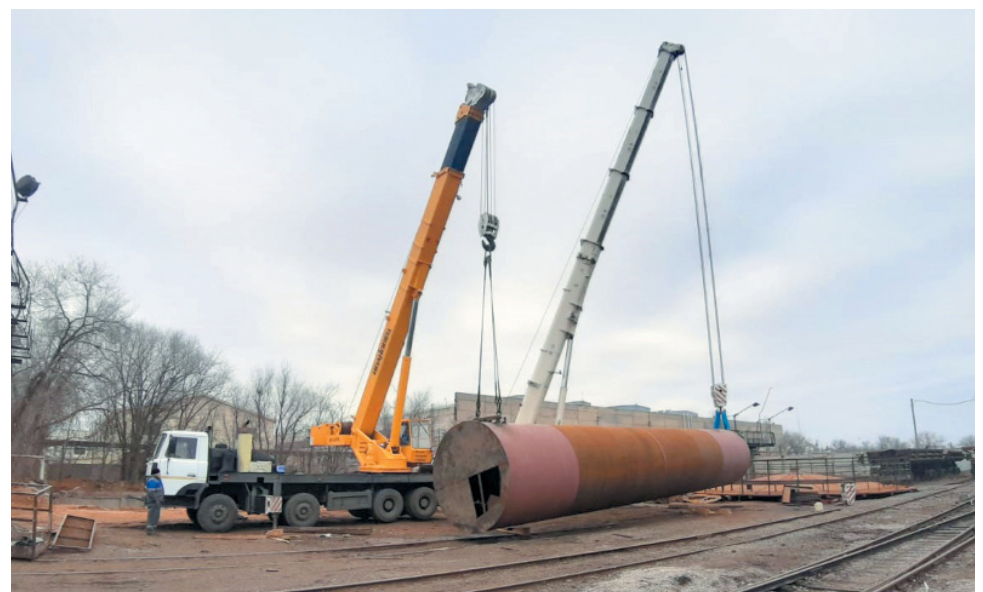
Совместный подъём ёмкости автокранами МЗКТ-6923-КС-6476 и DEMAG-TEREX AC-140
