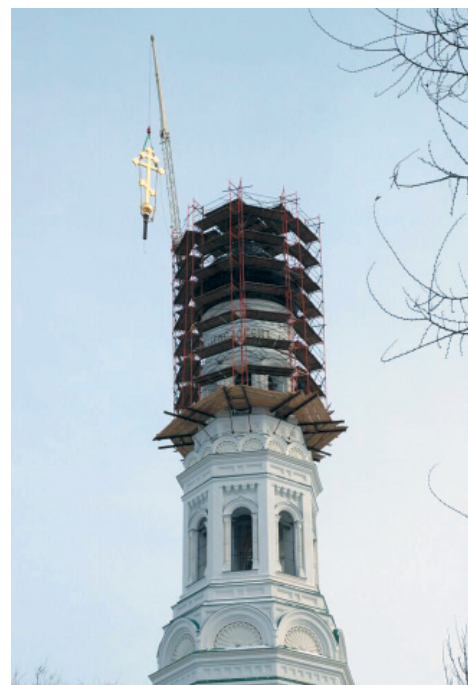
Установка креста на колокольню Храма Троицы Живоначальной
