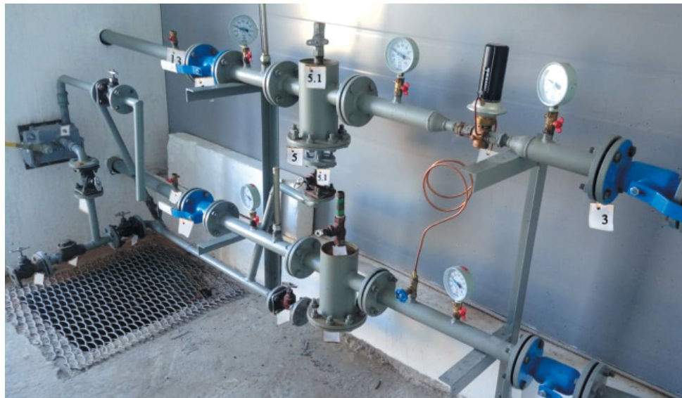
Тепловой пункт склада № 3 участка УМТР
