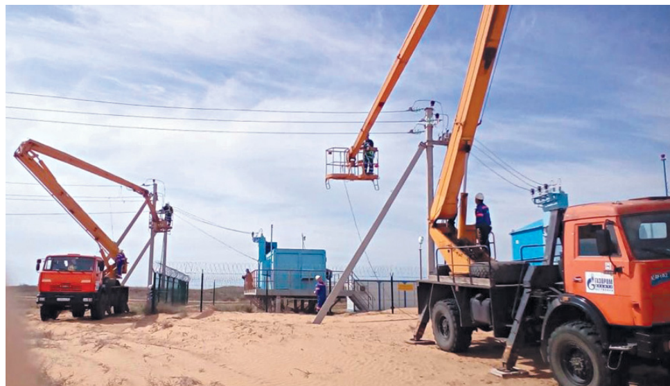
Ремонтные работы на линии электропередач
