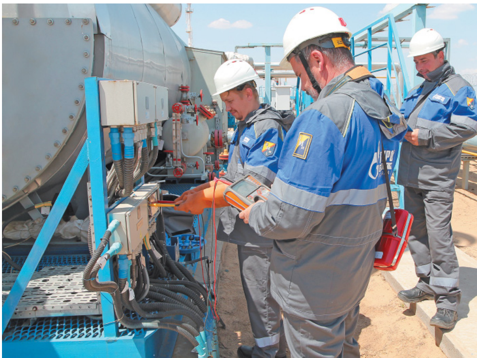
Измерение сопротивления изоляции кабель-линии
