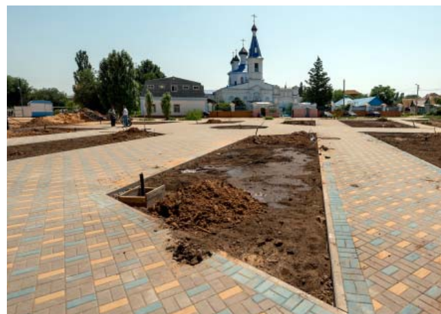
Строящийся парк Петра и Февронии в Трусовском районе
