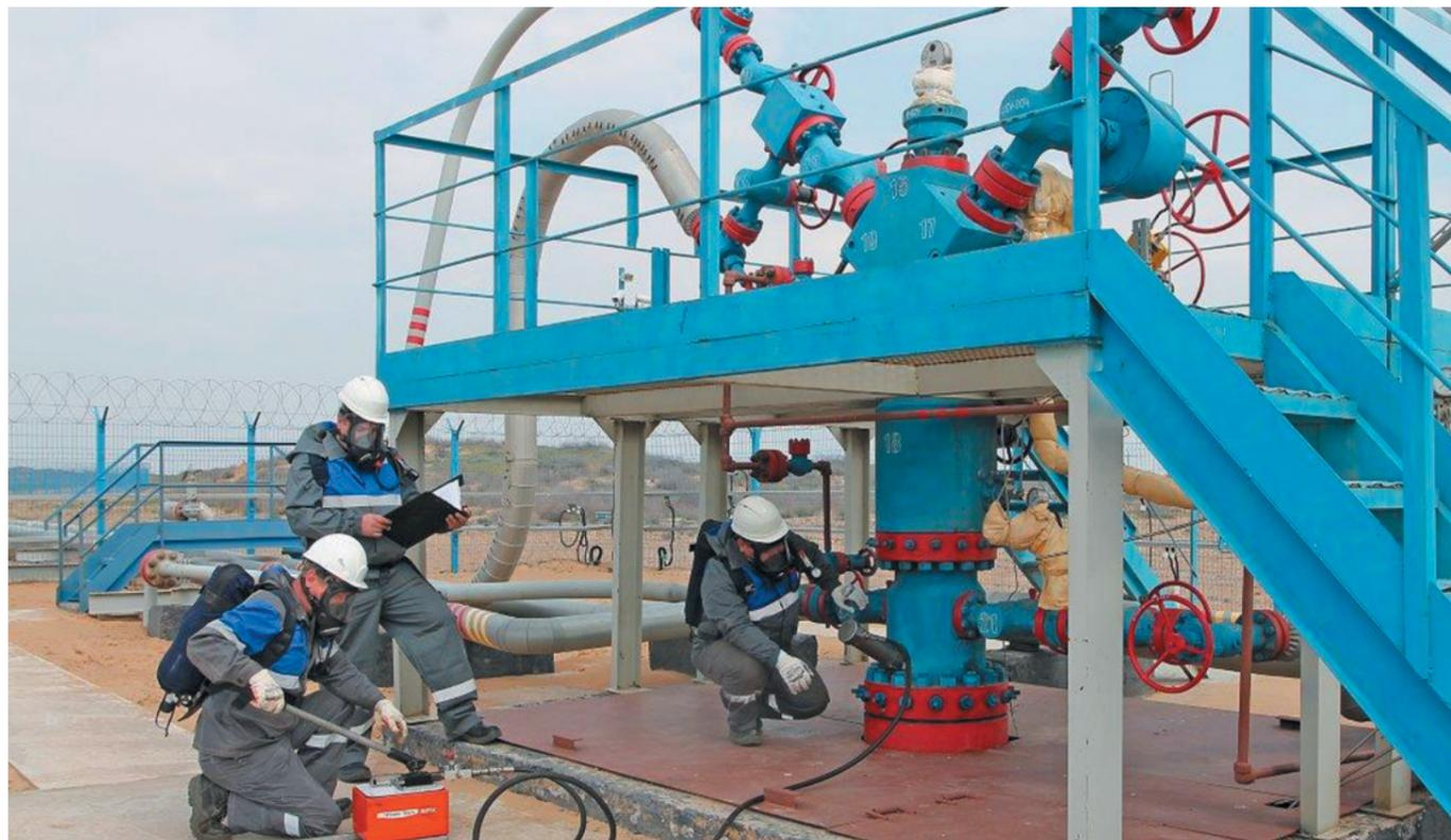
Закачка герметика в эластомерное уплотнение трубной головки
