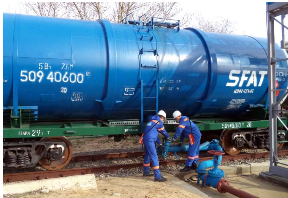
Слив дизельного топлива из железнодорожной цистерны с помощью установки нижнего слива УСН-150
