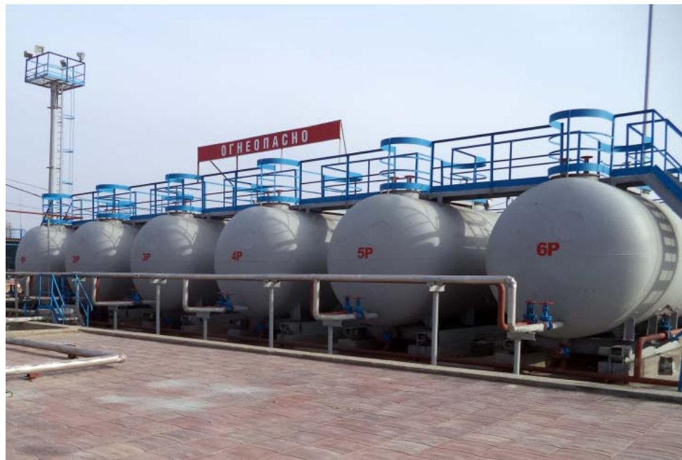
Участок хранения дизельного топлива и раствора ингибитора коррозии
