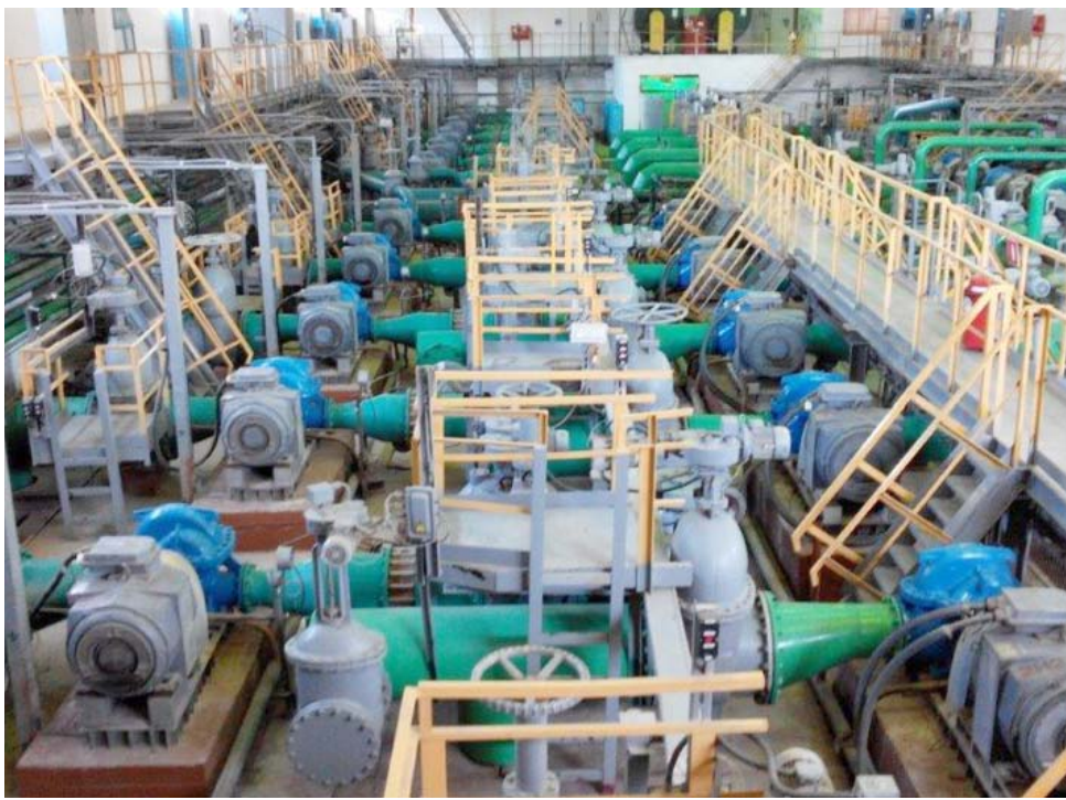
Насосная оборотного водоснабжения № 1
