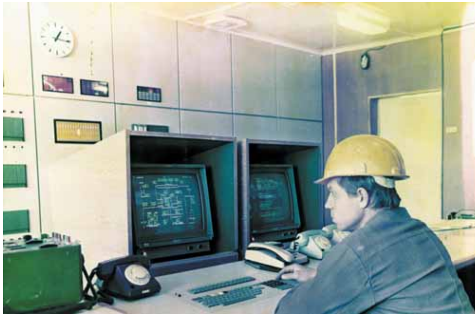
Система контроля и управления промыслом первой очереди АГКМ была введена в эксплуатацию в 1986 г. и согласно проекту обслуживала УППГ-1, 2, а также 77 скважин, 14 клапанных блоков и 5 пунктов контроля сероводорода.
