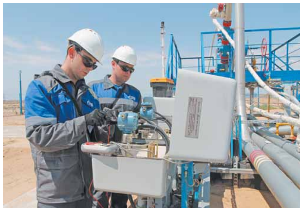
Обследование датчиков на эксплуатационной скважине
