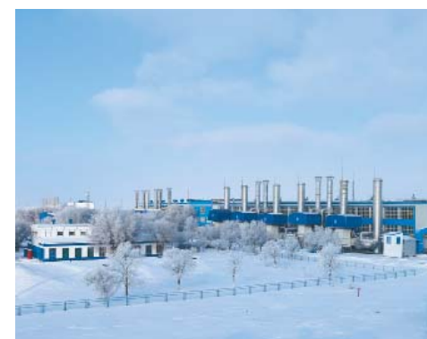
Компрессорная станция «Александров Гай»
