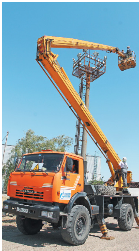
Ремонт светильника на мачте освещения
