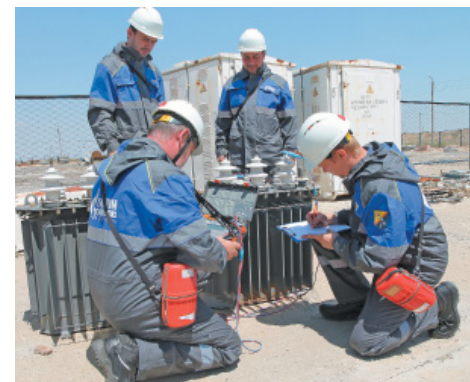
Проведение измерений на трансформаторе
