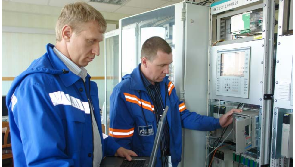
Предварительная настройка частотного преобразователя на лабораторном стенде
