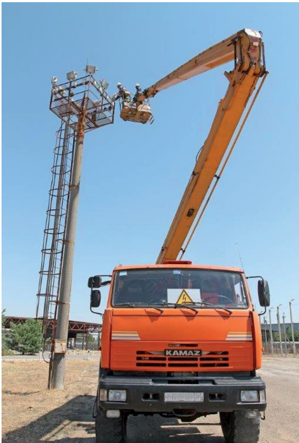
Ремонт светильника на мачте освещения
