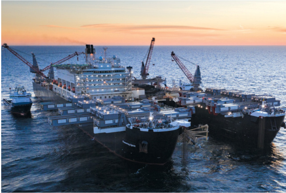
Строительство морской части газопровода «Северный поток-2»
