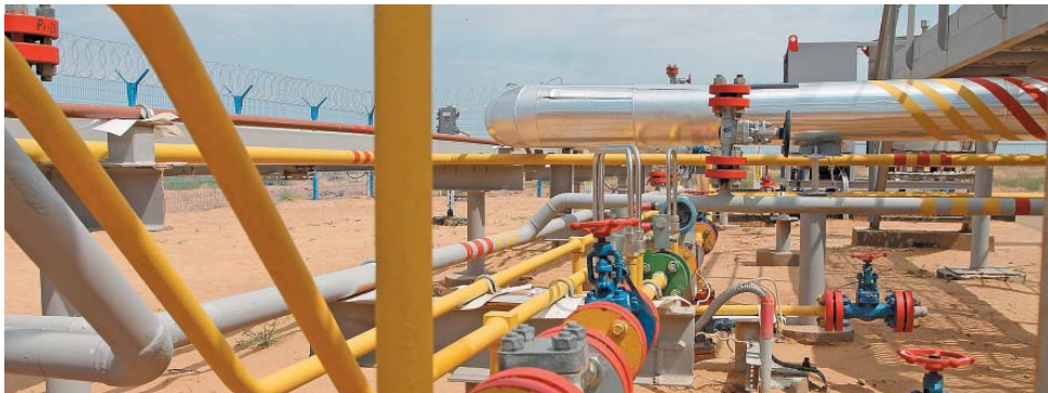
Скважина Газпромышленного управления
