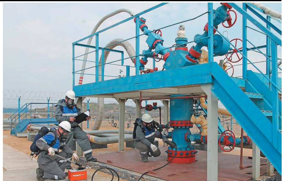
Закачка герметика в эластомерный уплотнитель трубной головки
