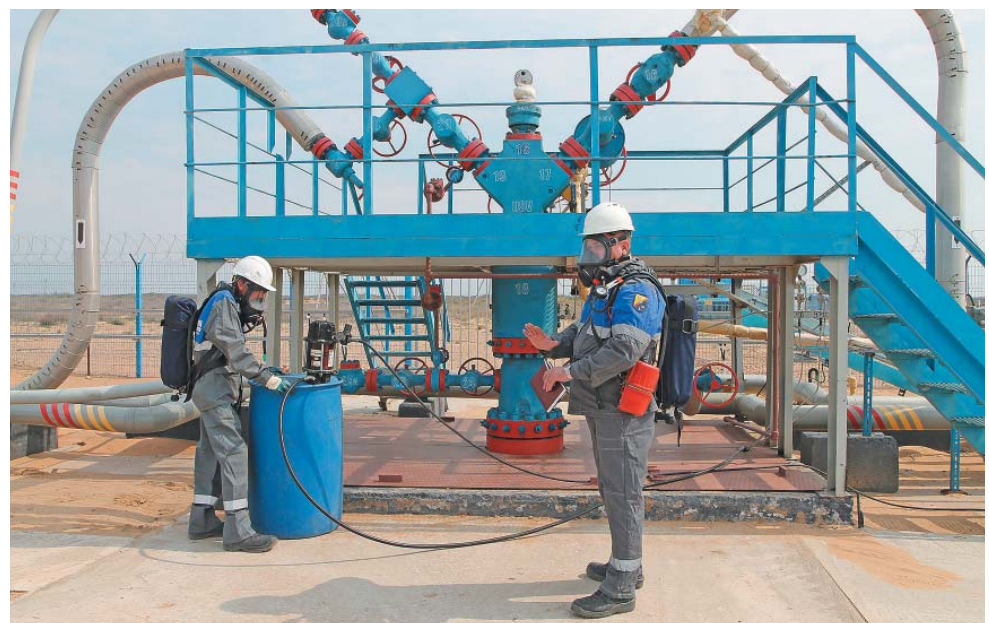
Закачка спецсостава в межколонное пространство скважины
