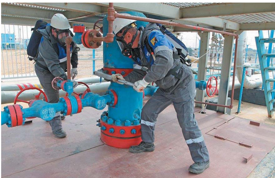
Подтяжка нажимных винтов уплотнителя металл-металл адаптера фонтанной арматуры
