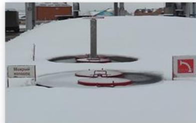
Колодец с пожарным гидрантом и установленной на нем пожарной колонкой
