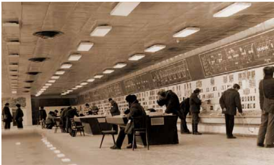
Операторная первой очереди завода, 1987 г.
