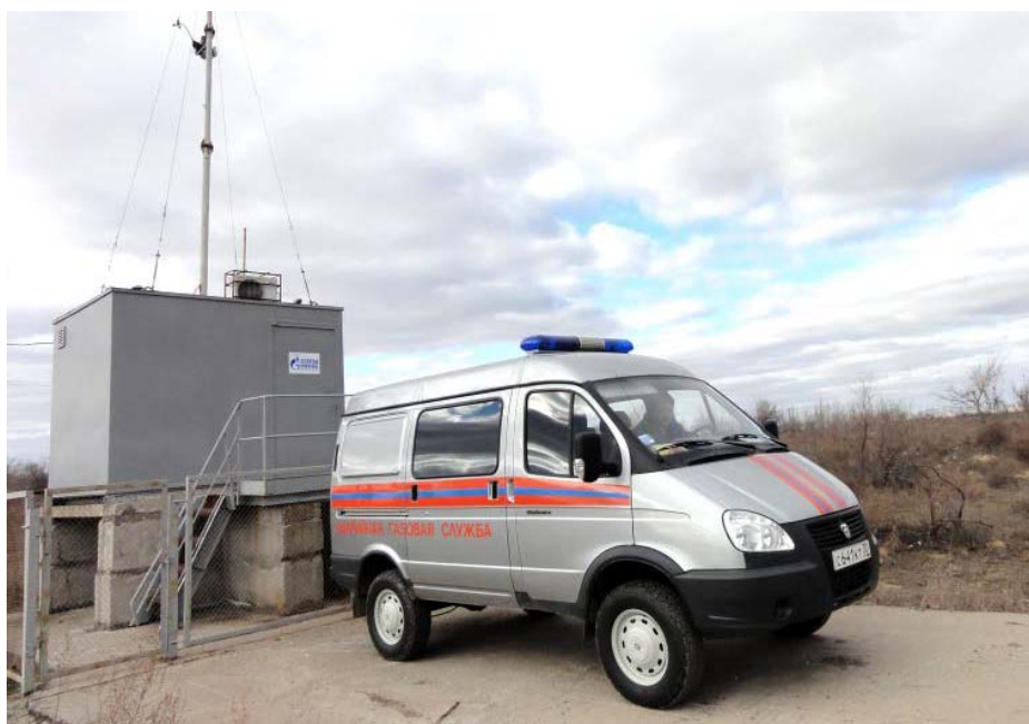
Пост контроля загрязнения атмосферного воздуха на границе СЗЗ
