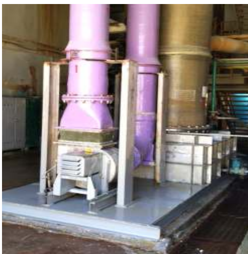
Установка У-150/1 «Devco» производства № 6 АГПЗ
